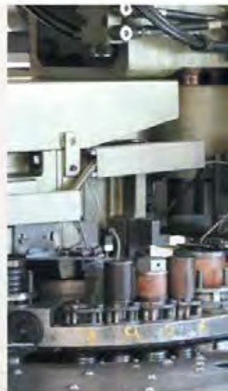
Atelier de soudure intégré
